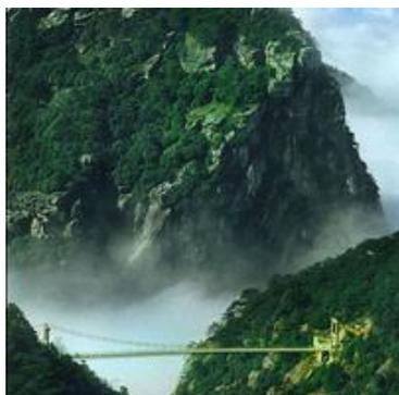
【介绍】：当地人又称铁索桥，座落在神龙宫地带，横跨于将军河面，悬空险秀，为庐山添一景。此桥，1993 年修。它的建成，既沟通他游览路线，又为提供观赏铁船峰和石门创造了最佳观景点，可谓一举两得。桥以四根铁管对应相参，再在上端并架铁索连接两岩高立钢盘水泥柱，斜拉组合吊力，加铺预制板面，牢固安全。登临桥上四顾神龙宫境。清幽雅然，铁船峰姿显示清晰，而传说中所讲帆船坠化巛上的轮廓历历映目，两峰并立有若门框之构成石门，溪流通过石门泻涧之声激昂悦耳，横生妙处。
